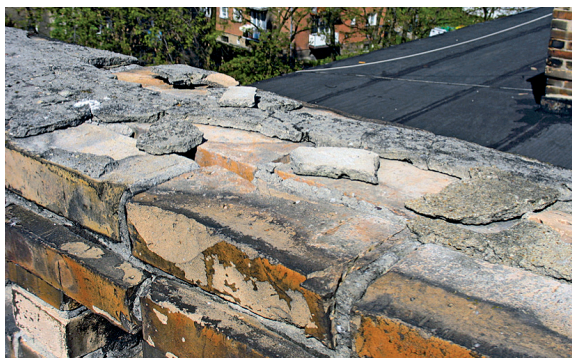
Fot. 3. Stan techniczny kominów
