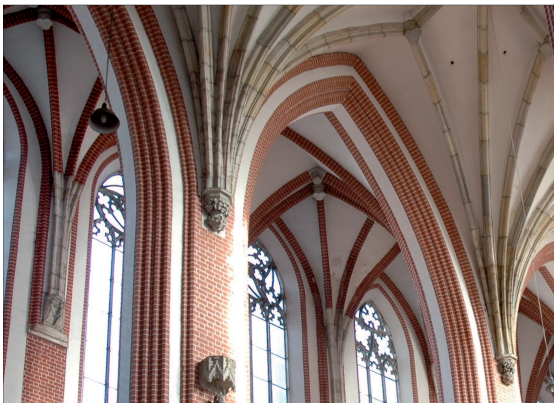
20. Wrocław – kościół NMP na Piasku, ośmioboczne filary z lizenami 20. Wrocław – the Church of Virgin Mary on the Sand, octagonal pillars with pilaster strips
