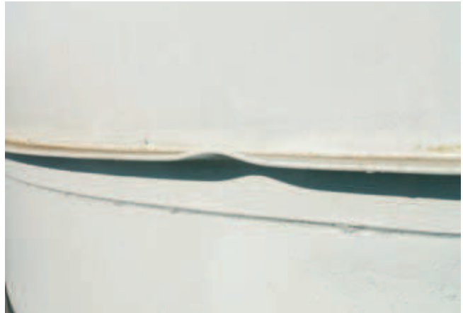
Rys. 2. Fragmenty lokalnie zdeformowanych i trwale odkształconych elementów zbiornika
