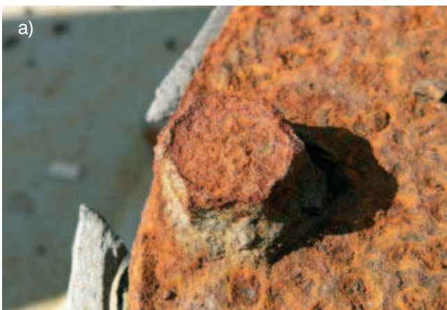
Rys. 3. a) Przykład procesu korozyjnego stalowych elementów konstrukcyjnych, b) wady w strefie podparcia konstrukcji wsporczej na powierzchni stopy fundamentowej
