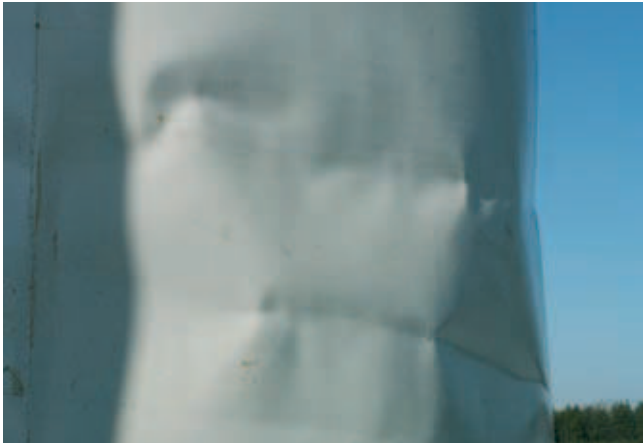
Rys. 2. Fragmenty lokalnie zdeformowanych i trwale odkształconych elementów zbiornika
