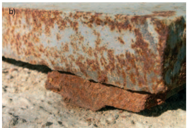
Rys. 3. a) Przykład procesu korozyjnego stalowych elementów konstrukcyjnych, b) wady w strefie podparcia konstrukcji wsporczej na powierzchni stopy fundamentowej
