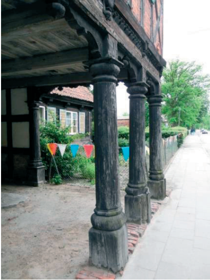
Fot. 9. Dom podcieniowy w Żuławkach. (fot. Autor)
