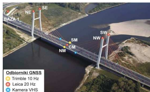
Rys. 1. Rozmieszczenie odbiorników GNSS na moście Siekierkowskim
