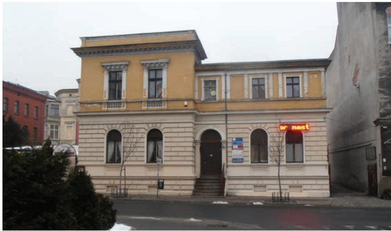
Budynek przy ulicy Piotra Skargi 3, w którym od 1936 r. do połowy lat 50. mieścił się Miejskowy (później Obwodowy) Urząd Miar w Bydgoszczy – stan obecny
