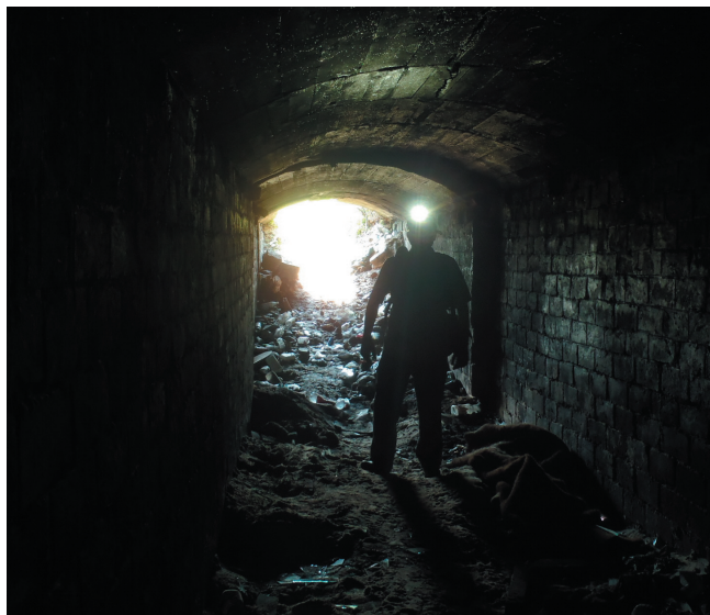
Ryc. 3. Jedna z dobrze zachowanych sztolni technicznych w Rudkach (fot. Artur Komorowski)
