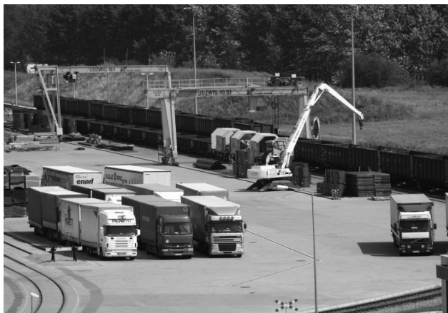
Rys.1. Fragment granicznego rejonu przeładunkowego w Medyce z frontem ładunkowym do przeładunku towarów sypkich i sztukowych [15]
