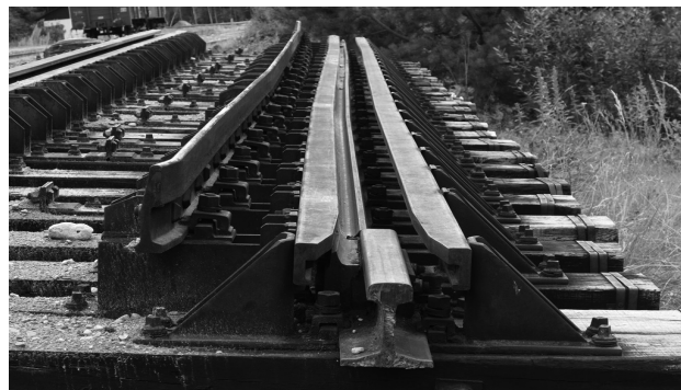
Rys. 15. Zdemontowane torowe stanowisko przestawcze SUW 2000 w Mockawie [14]
