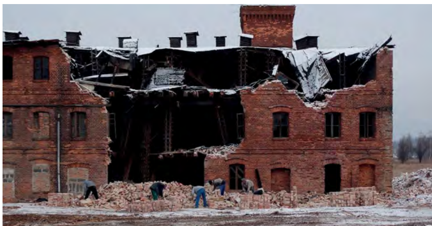
Rys. 9. Pracownicy ręcznie sortują cegłę z rozbiórki dawnej cegielni w Jeleniej Górze [13]
