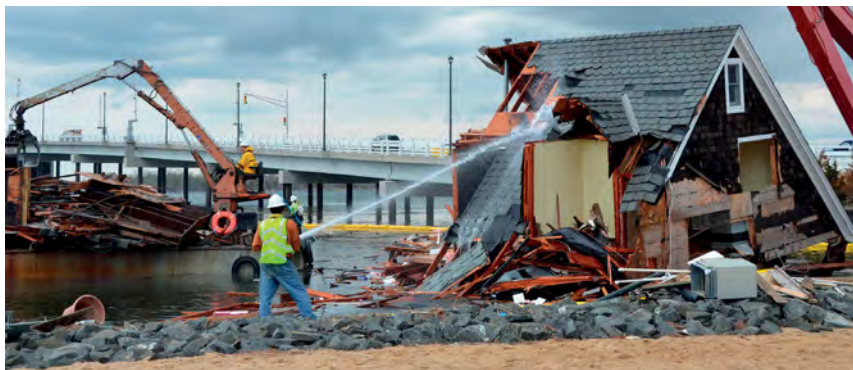
Rys. 11. Wykonawca polewa wodą dach budynku w celu zmniejszenia zapylenia podczas rozbiorczy [12]
