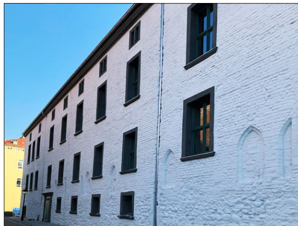
Ryc. 2. Dawny klasztor Magdalenek, widok od północnego zachodu, stan po pracach; fot. autor.
