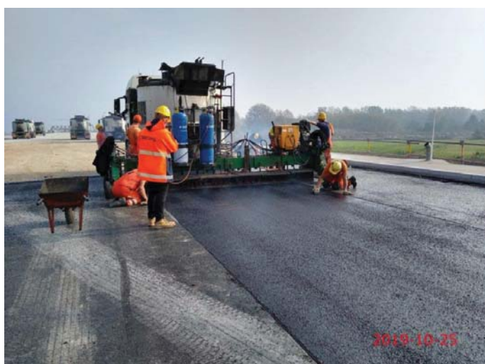
Fot. 5. Układanie MA na obiekcie nr 4. Źródło: GDDKiA
