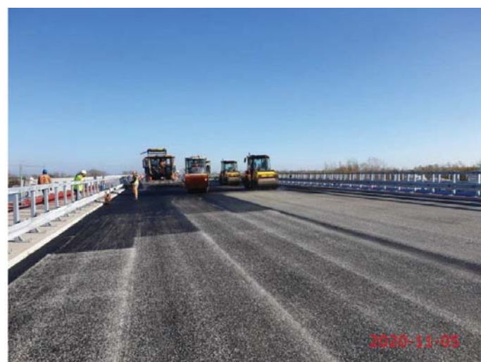
Fot. 6. Układanie SMA na obiekcie nr 2. Źródło: GDDKiA
