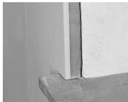
Rys.4. Aerowelna jako izolacja od wewnątrz [9].
