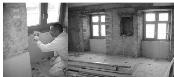
Rys.3. Zastosowanie izolacji z aerożelu w miejscu pocienienia ściany zewnętrznej [6].
