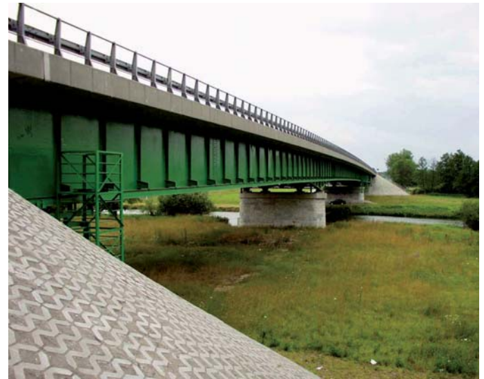
Fot. 1. Most przez rzekę Wieprz w Kośminie (źródło: strona internetowa GDDKiA)
