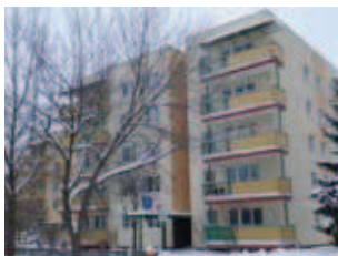
Rys. 9. Widok budynku po ociepleniu [3]
