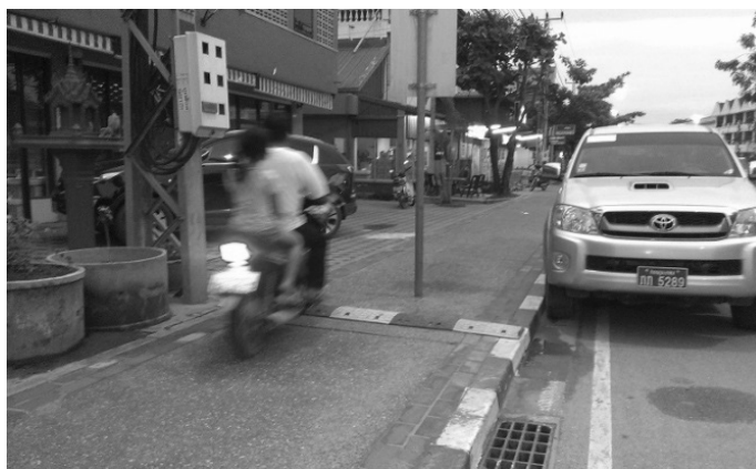
Fot. 6. Próg zwalniający na chodniku zastosowany w celu spowolnienia ruchu skuterów. Źródło: Materiał własny.
