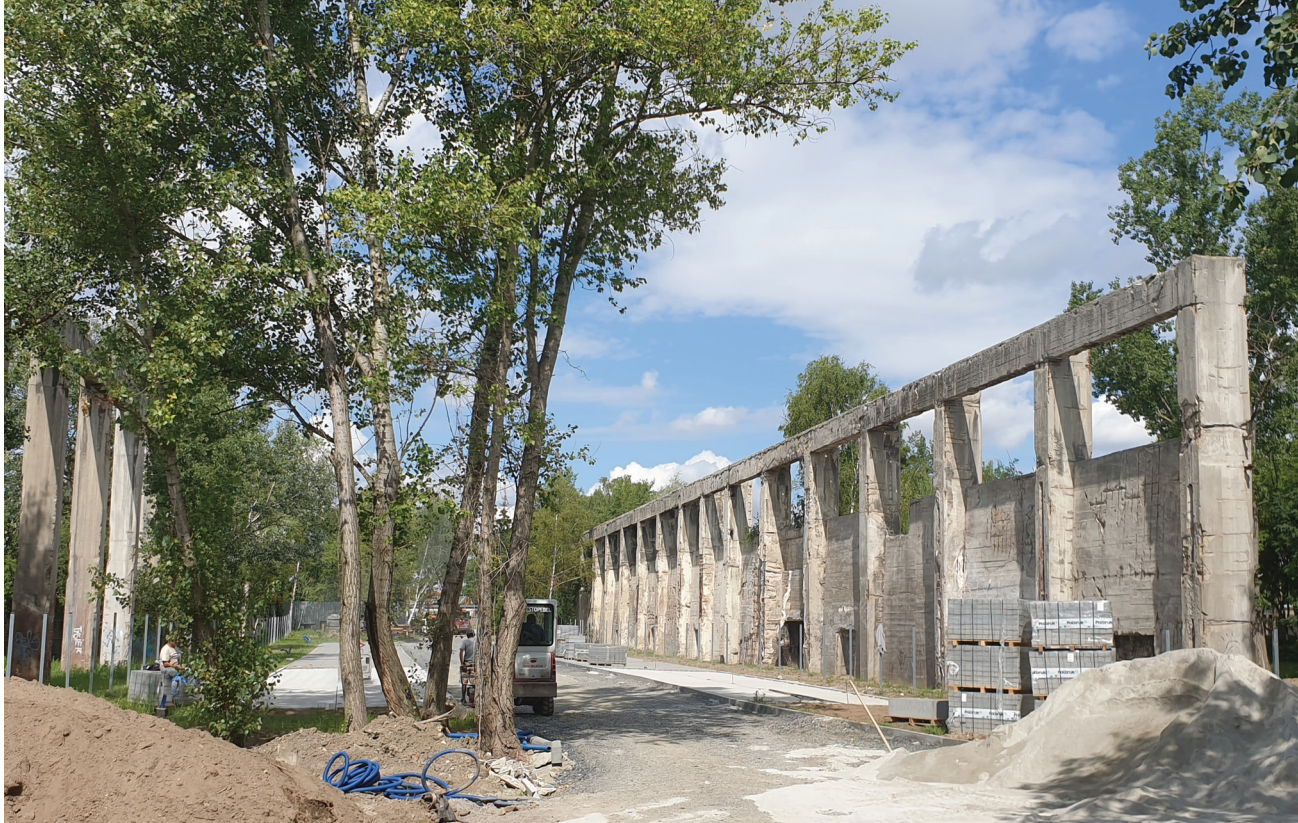
Fot. 9. Budowa parkingu, fot. autorki, sierpień 2021
