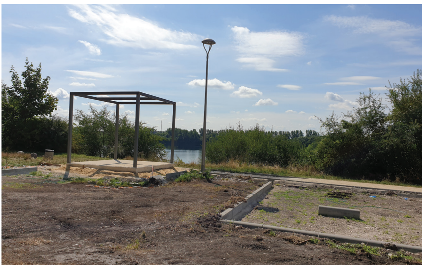
Fot. 6. Budowa altan i ścieżek, fot. autorki, sierpień 2021
