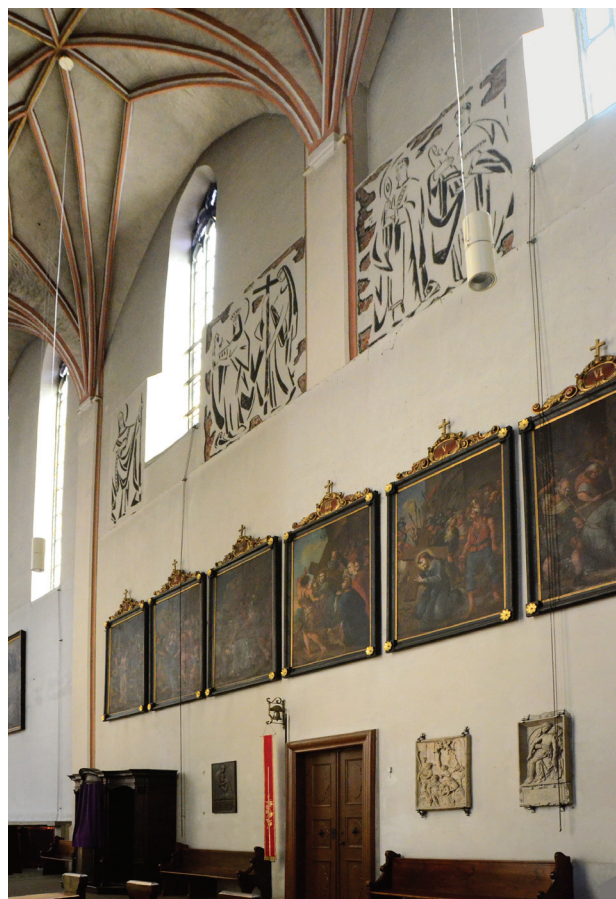
Il. 7. Opole – katedra, ściana południowa korpusu za zmianami grubości
