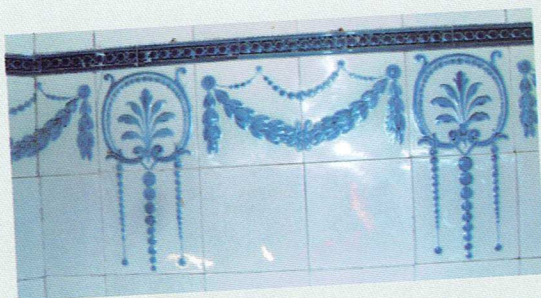
Fot. 5. Dwubarwne płytki ceramiczne zdobione reliefem wypukłym w oryginalnym układzie kompozycyjnym
