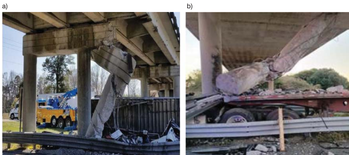
Fot. 6. Przykłady uderzenia ciągników z naczepą w filary wiaduktów: a) zniszczony filar wiaduktu w Orangeburgu, Karolina Płd., USA [19]; b) całkowicie zniszczony słup filara przez ładunek w New Madrid County, USA [20]
