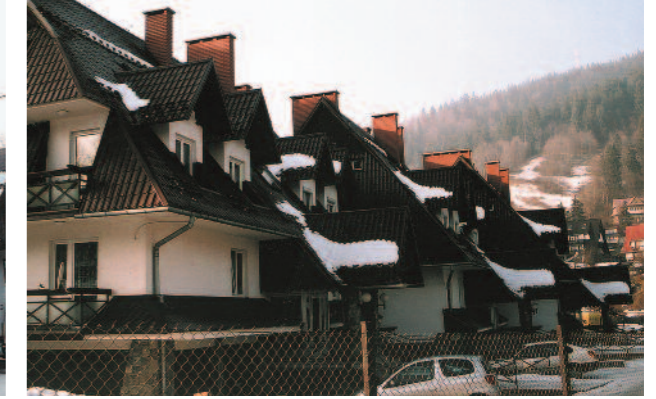
▲ Zespół budynków mieszkalnych przy ulicy Szkołnej, Zakopane. A complex of multifamily residential buildings in Szkołna St., Zakopane.
