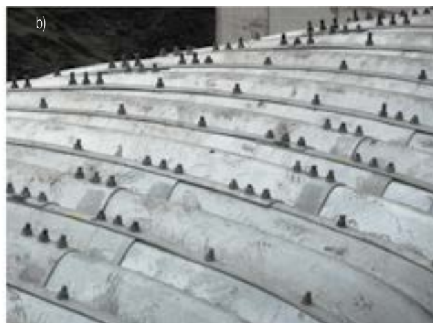
Ryc. 5. Sposób połączenia poszczególnych segmentów blach za pomocą śrub: a) schemat typowego połączenia [11], b) widok wykonanego połączenia konstrukcji typu Multiplate na etapie budowy, fot. A. Wysokowski
