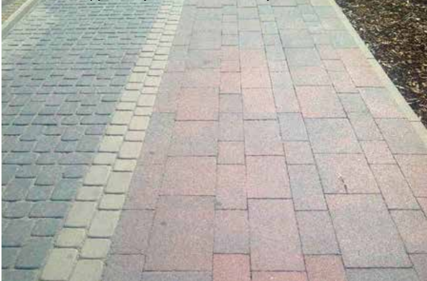
Fot. 7. Przykład realizacji ciągu pieszo-jezdnego z bruków fotokatalitycznych – ścieżka rowerowa z płyt bezzfazowych i chodnik z kostek fazowanych
