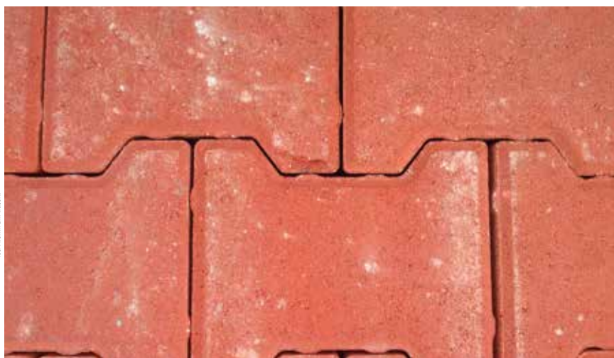
Fot. 1. Widok przewibrowanej nawierzchni betonowej – nadmierne przetarcie zaczynu
