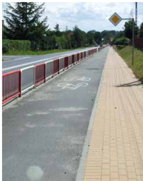
Fot. 2. Przykład kolorystyki nawierzchni ścieżki i przyległego chodnika – teren zabudowany
