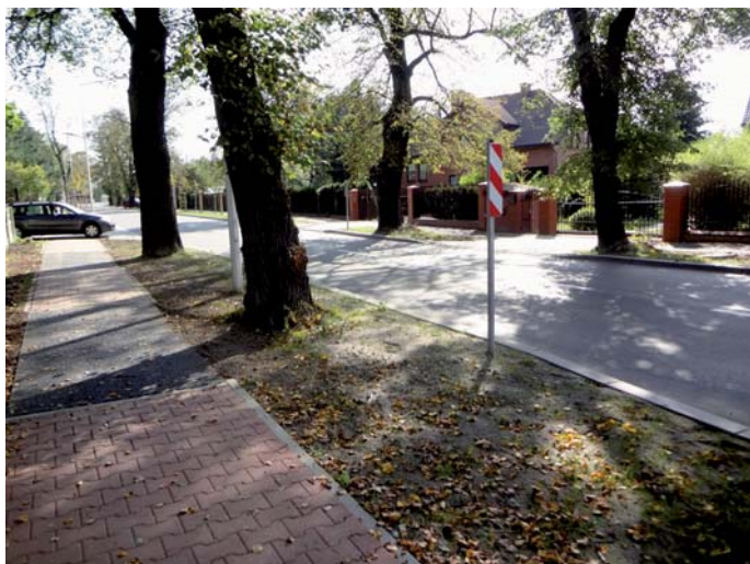
Fot. 2. Modyfikacja rodzaju nawierzchni w sąsiedztwie drzew – zamiana nawierzchni nieprzepuszczalnej na porowatą
