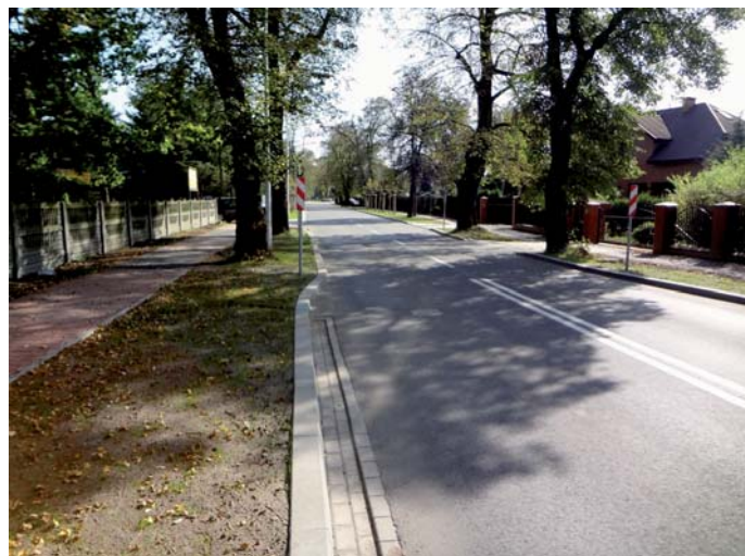
Fot. 1. Miejscowe zwężenie ulicy, które pozwoliło na zachowanie cennych drzew (fot. M. Suchocka)
