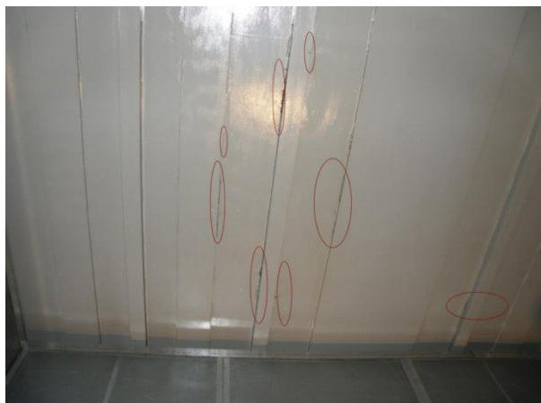
Rys. 1. Widok fragmentu konstrukcji płyty spodniej generatora
