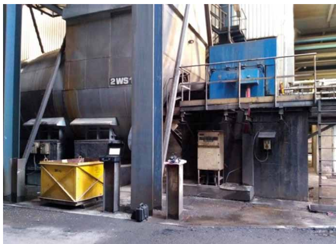
Rys. 1. Silnik wentylatora spalin na stanowisku pracy w elektrowni, cewka pomiarowa umieszczone za wentylatorem
