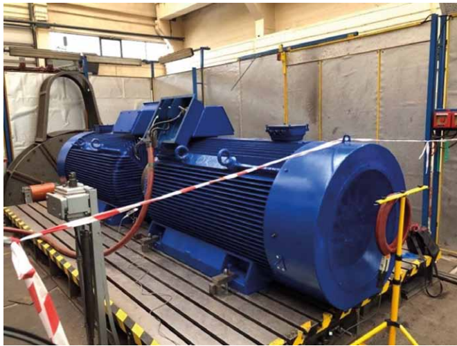
Rys. 9. Silnik 1000 kW obciążany na stanowisku w stacji prób przez identyczną maszynę
