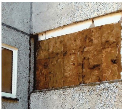
Rys. 7. Fragment ściany po odpadnięciu warstwy fakturowej (z lewej) oraz widok pękniętego wieszaka (z prawej) [7]
