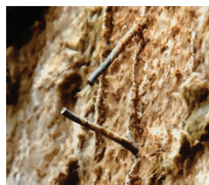
Rys. 7. Fragment ściany po odpadnięciu warstwy fakturowej (z lewej) oraz widok pękniętego wieszaka (z prawej) [7]
