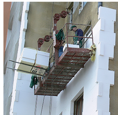
Rys. 2. Dodatkowe docieplenie ścian zewnętrznych budynku wielkopłytowego [8]
