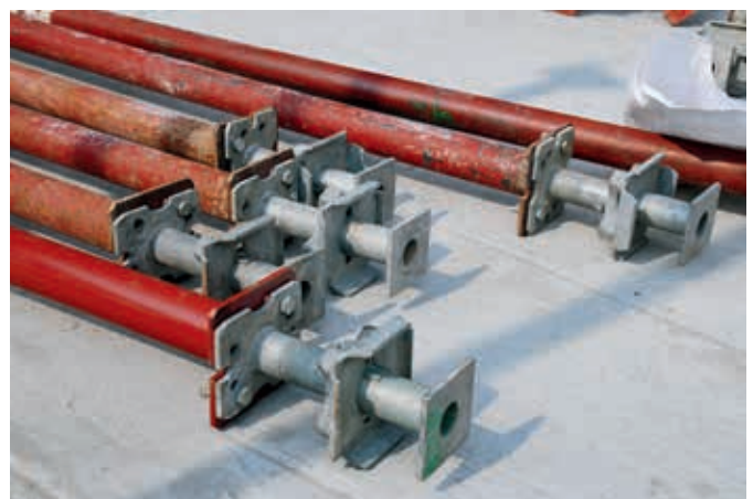
Głowice opadające zamontowane wstępnie na podporach
