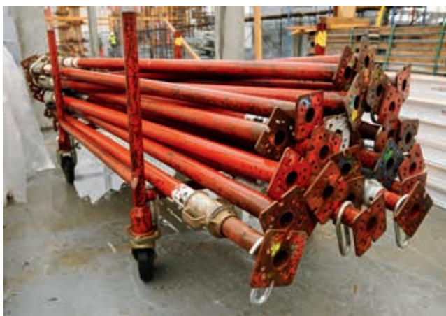
Podpory stalowe umieszczone na barełce
