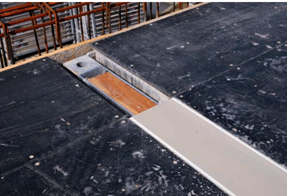
Powierzchnia deskowania – systemowe pasy uzupełniające wypełniające przerwy między panelami
