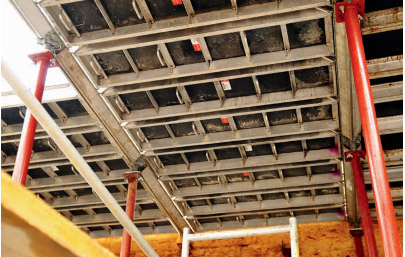
Widok typowego układu pola roboczego deskowania z zastosowaniem paneli HV
