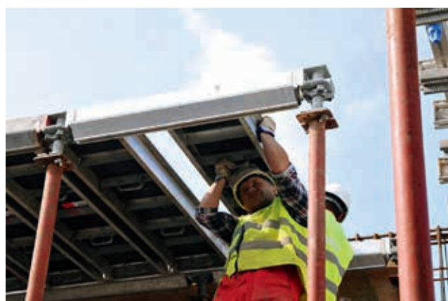
Układanie paneli HV na dźwigarach
