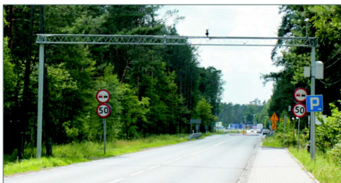
Fot. 1. Widok ogólny stacji ważenia pojazdów w ruchu na drodze krajowej nr 46 w m. Grodziecu
