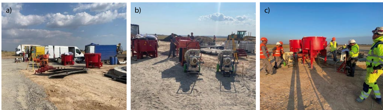
Rys. 4. Ogólny widok budowy: a) widok lokalizacji niezbędnego sprzętu, b) lokalizacja pomp, c) mieszalniki potrzebnej objętości, V-1700 l każda
