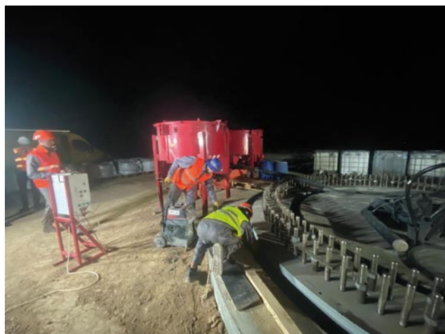
Rys. 5. Przygotowanie miejsca podlewowego, przepompowanie wody
