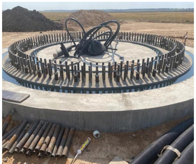
Rys. 2. Ogólny widok fundamentu z miejscem, wypełnionym wodą, gdzie będzie wykonana podlewka (fot. autora)
