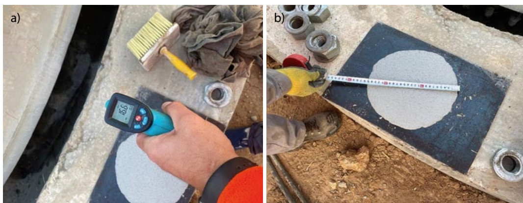
Rys. 6. Wykonanie niezbędnych pomiarów parametrów technologicznych przed rozpoczęciem robót: a) pomiar temperatury, b) pomiar płynności metodą stożkową ASTM-C230
