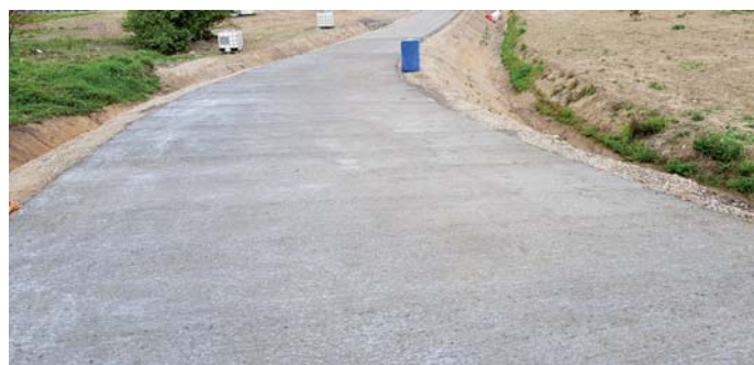
Fot. 11. Odcinek doświadczalny – ułożona mieszanka RCC-C30/37 na kruszywie granitowym do 16 mm, cement CEM1
