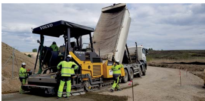
Fot. 7. Odcinek doświadczalny – rozładunek mieszanki RCC do kosza zasypowego rozścielacza
