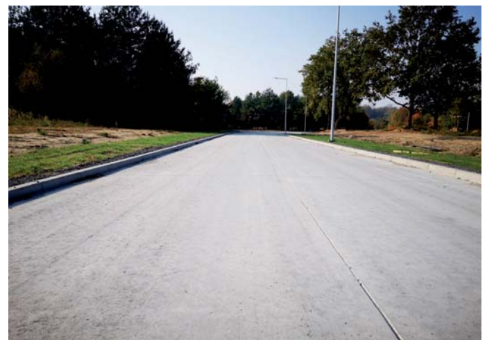
Fot. 6. Drogi na terenie strefy inwestycyjnej w Żaganiu
