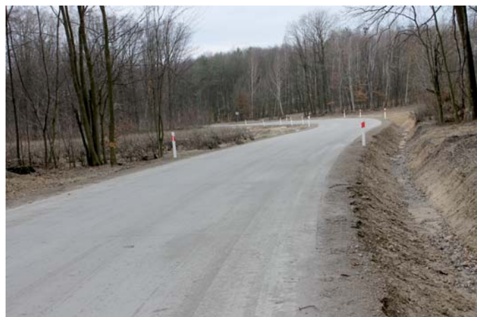
Fot. 2. Droga lokalna Chruślanki Józefowskie – 3,2 km drogi w technologii RCC
