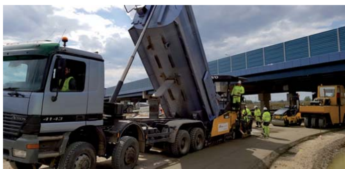
Fot. 1. Odcinek DD52 przy budowie drogi ekspresowej S51 (Paweł Białek, Cemex)
