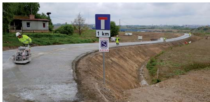
Fot. 12. Odcinek doświadczalny – nacinanie dylatacji pozornych
