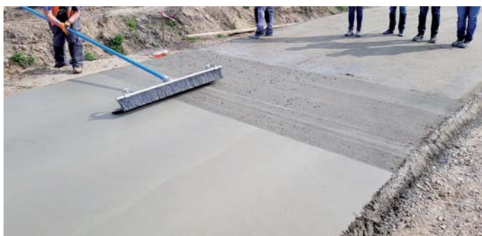
Fot. 8. Odcinek doświadczalny – teksturowanie przy użyciu szczotki
