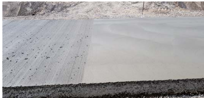
Fot. 10. Odcinek doświadczalny – efekt po „zatarciu” nawierzchni zacieraczką a także po nadaniu struktury z użyciem szczotek ze sztywnym włosiem
