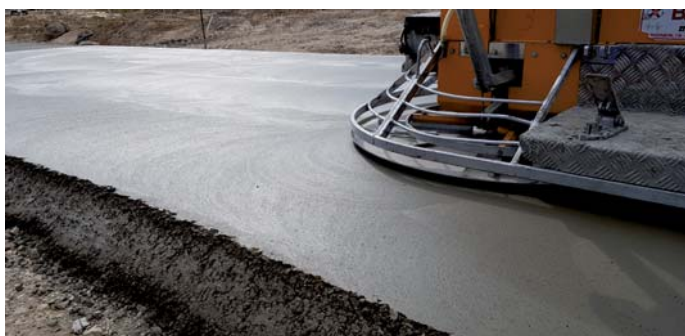
Fot. 9. Odcinek doświadczalny – zacieranie nawierzchni z betonu wałowanego
