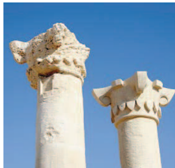
Ryc. 15. Marina El-Alamein. Dom H21c. Pomnik Komemoratywny. Kapitele kolumn: oryginalny i rekonstruowany na jego wzór (fot. R. Czerner) Fig. 15. Marina El-Alamein. House 21c. The Commemorative Monument. Column capitals: the original and its reconstruction (photo: R. Czerner)
