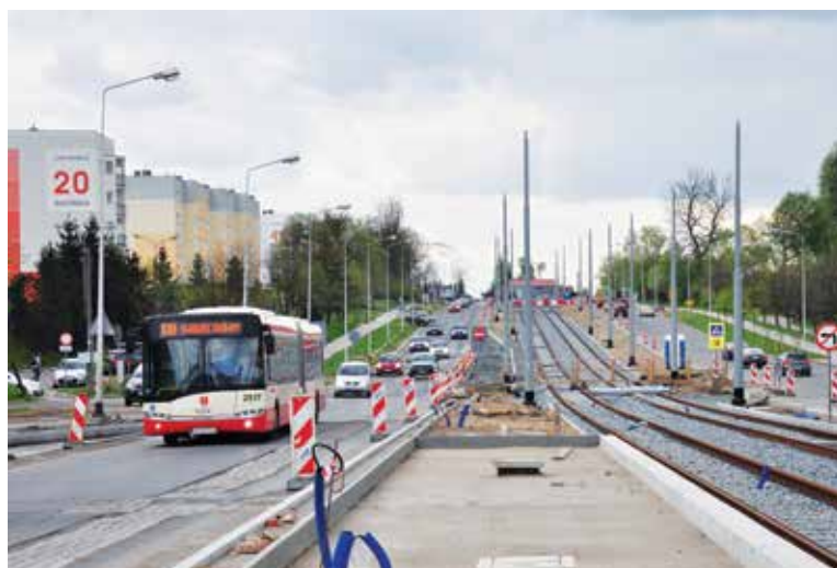
Fot. 5. Budowa infrastruktury torowej na ul. Bulońskiej w ciągu trasy tramwajowej do dzielnicy Morena. Fot. K. Jacobson
