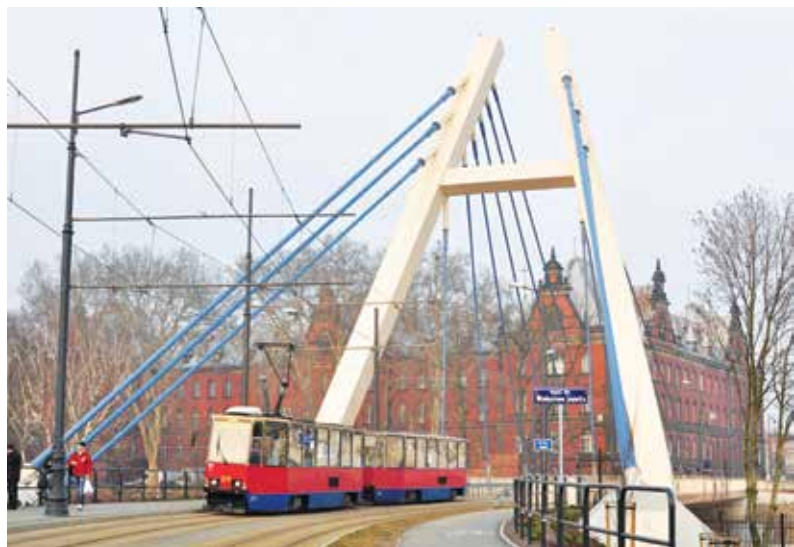
Fot. 2. Dwuskład tramwajów Konstal 805Na na nowym moście tramwajowym nad Brdą w ciągu trasy do dworca kolejowego. Fot. K. Jacobson
