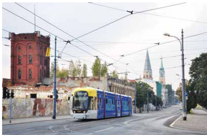
Fot. 1. Tramwaj Bombardier Cityrunner #1206 przejeżdżający wyremontowanym torowiskiem na ul. Piotrkowskiej. Fot. K. Jacobson
