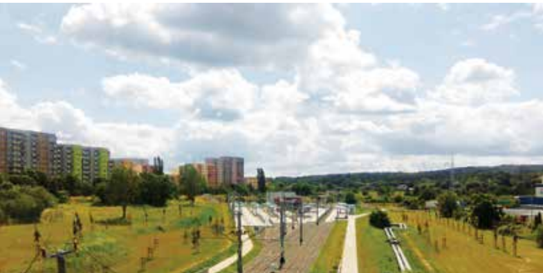
Fot. 11. Pętla trasy Szczecińskiego Szybkiego Tramwaju przy ul. Turkusowej. Fot. J. Górny
