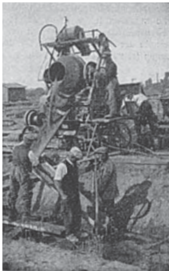
Fot. 2. Przebieg palowania w części zalewowej mostu [1]
