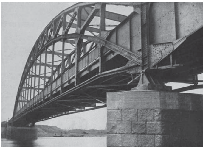
Fot. 6. Widok na przęsło nurtowe z prawego brzegu rzeki Warty od wody górnej [2]
