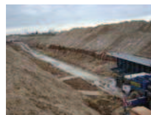
Rys. 5. Zalana droga dojazdowa przez spływającą wodę
