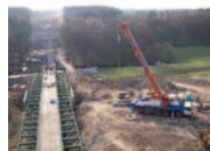
Rys. 4. Widok z pylonu nasuwczego na dolinę rzeki
