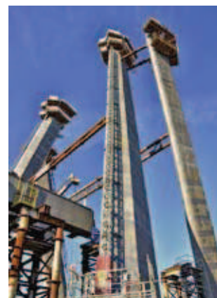
Rys. 11. Podest ruchomy masztowy na odcinkach prostych pylonu
