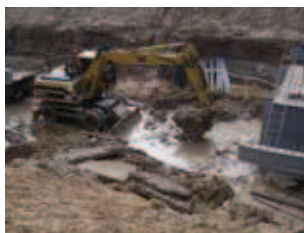
Rys. 6. Przygotowanie terenu do wykonania podpory montażowej
