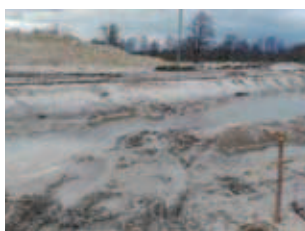
Rys. 19. Wykop pod fundament podpory P3 obiektu MS5-9a
