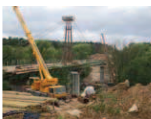
Rys. 9. Nasuwanie konstrukcji stalowej estakady – widok od strony przyczółka
