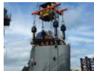
Rys. 10. System do montażu precyzyjnego
