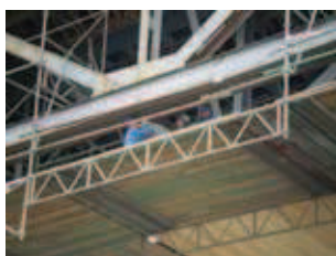
Rys. 3. Przyklejanie taśm na pasy dolne, rozciągane
