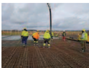
Rys. 17. Betonowanie ustroju nośnego obiektu MS5-7 jezdni prawa
