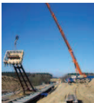
Rys. 7. Stawianie pylonu nasuwczego
