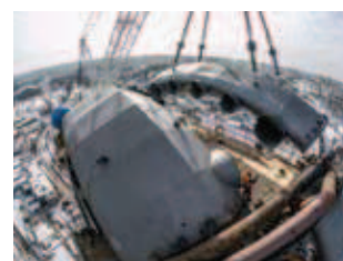
Rys. 12. Montaż klucza tuku pylonu Omega
