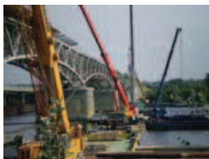
Rys. 1. Widok ogólny mostu w miejscowości Chełmno w trakcie prowadzenia robót
