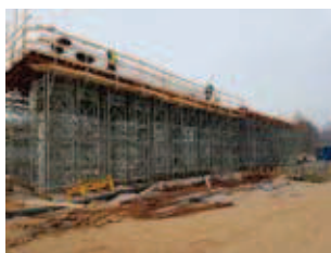
Rys. 16. Rusztowanie poprzecznic podpory pośredniej na obiekcie MS5-9a
