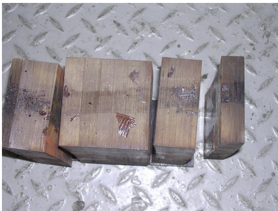
Rys. 7. Zniszczone mocowanie rdzenia i przesunięte fragmenty rdzenia
