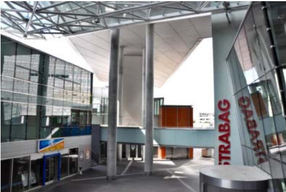
Il. 11. Widok na wewnętrzny dziedziniec budynku Strabag Haus przykryty szklanym dachem (fot. Katarzyna Zawada-Pęgiel, stan z roku 2015).
