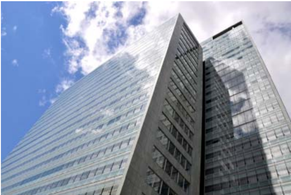
Il. 9. Fasada biurowca Ares Tower (fot. Katarzyna Zawada-Pęgiel, stan z roku 2015).
