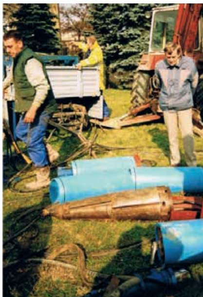
Ryc. 1. Prof. Andrzej Kuliczkowski (po prawej stronie) w trakcie prac przygotowawczych do rozpoczęcia bezwykopowego powiększenia przewodu kanalizacyjnego. Na zdjęciu widoczne są: głowica hydrauliczna, krótkie moduły rur PE-MD oraz osprzęt instalacyjny w trakcie wyładunku na plac w pobliżu ul. Rzeszowskiej w Dębicy
