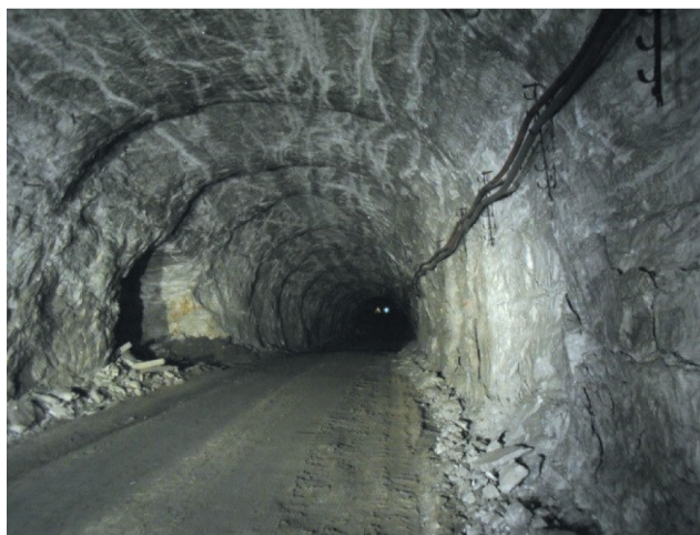
Rys. 3. Wyrobisko drażone w pokładzie soli
