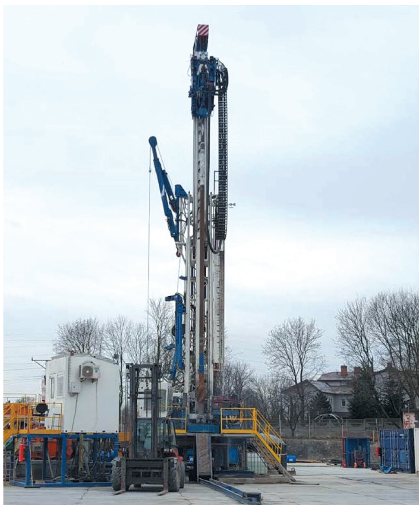
Rys. 6. Odwiert geotermalny w Tomaszowie Mazowieckim
