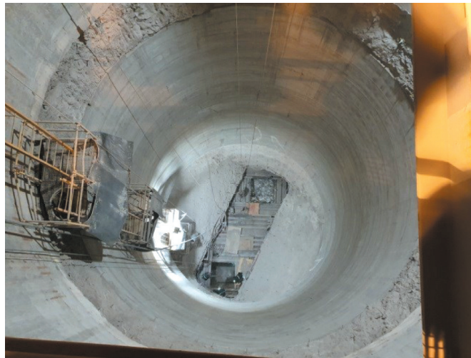
Rys. 5. Zbiornik urobku na etapie robót górniczych
