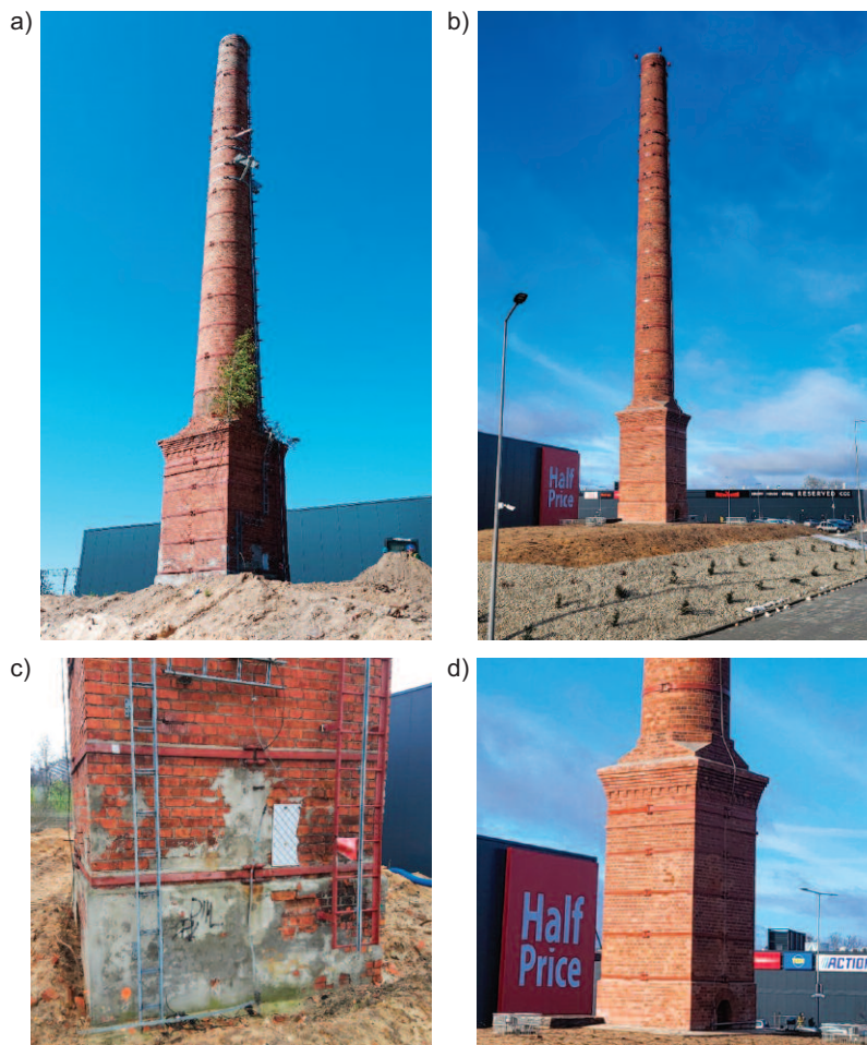
Photo 7. Comparison of chimney condition: a), c) – before revitalisation, May 2023; b), d) – after revitalisation, February 2024 Fot. 7. Porównanie stanu technicznego komina: a), c) – przed rewitalizacją (maj 2023 r.); b), d) – po rewitalizacji (luty 2024 r.)
