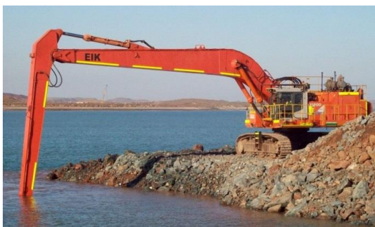
Rys. 2. Koparka kształtująca dno zbiornika wodnego [2]
