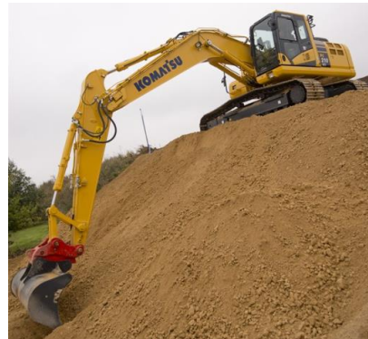
Rys. 4. Koparka w trakcie skarpowania [4]
