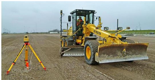
Rys.1. równiarka podczas niwelowania terenu [1]
