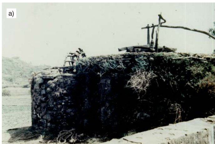
Fot. 7. Urządzenie podnoszące wodę w wiosce na Jawie: a) kierat napędzany siłą ludzkich mięśni, b) koło wodne z bambusowymi czerpakami
