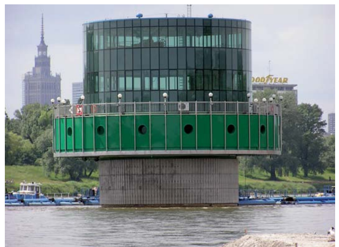
Fot. 18. Nowe ujęcie wody w Warszawie. Wiślana studnia zwana „Grubą Kašką”, wokół której pływają segmenty rurociągu pogłębiarki rzecznej
