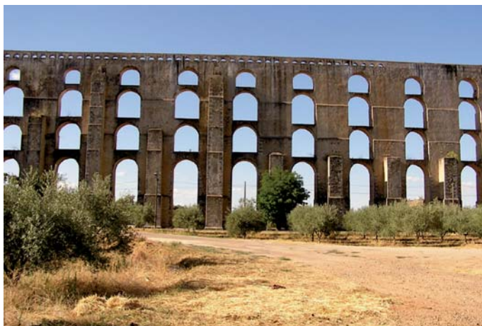
Fot. 12. Akwedukt Amoreira w Portugalii [5]
