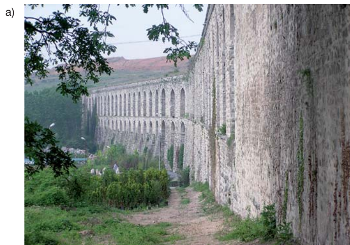
Rys. 2. Sposoby doprowadzania wody w Cesarstwie Rzymskim [1]: a) kanałami, b) rurami
