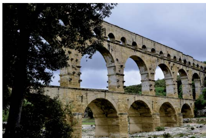
Fot. 10. Akwedukt du Gard w południowej Francji
