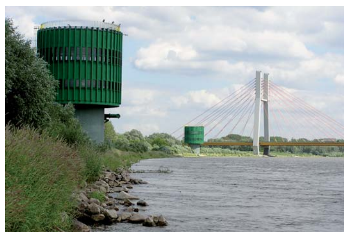
Fot. 19. Nowe studnie ujęcia wody. W głębi widoczny pylon mostu Siekierkowskiego
