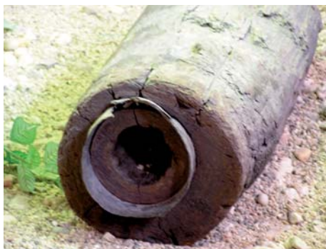
Fot. 14. Rury z drewnianych pni w średniowiecznych wodociągach Warszawy
