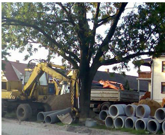
Rys. 6. Zagęszczenie gleby w obrębie korzeni Fig. 6. Soil compaction within the root placement
