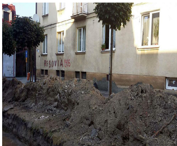
Rys. 7. Podwyższenie poziomu gruntu Fig. 7. Raising the ground level
