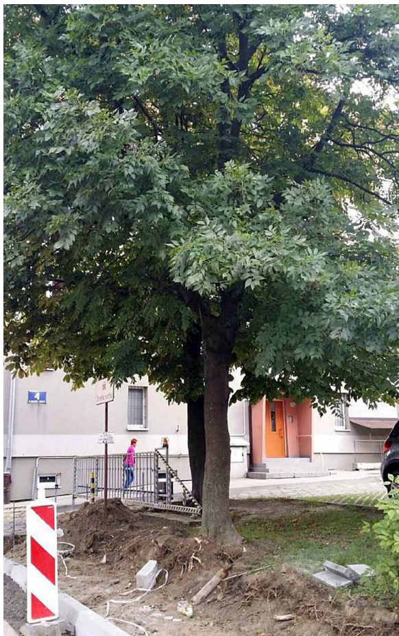
Rys. 2. Uszkodzenia mechaniczne korzeni Fig. 2. Mechanical damage to the roots
