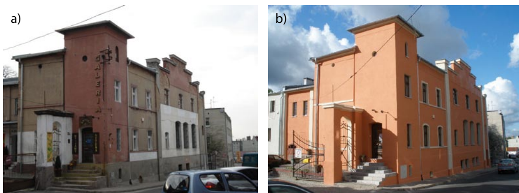
Rys. 1. Elewacja od strony ulicy Fabrycznej (część pierwsza): a) przed adaptacją, b) po adaptacji
