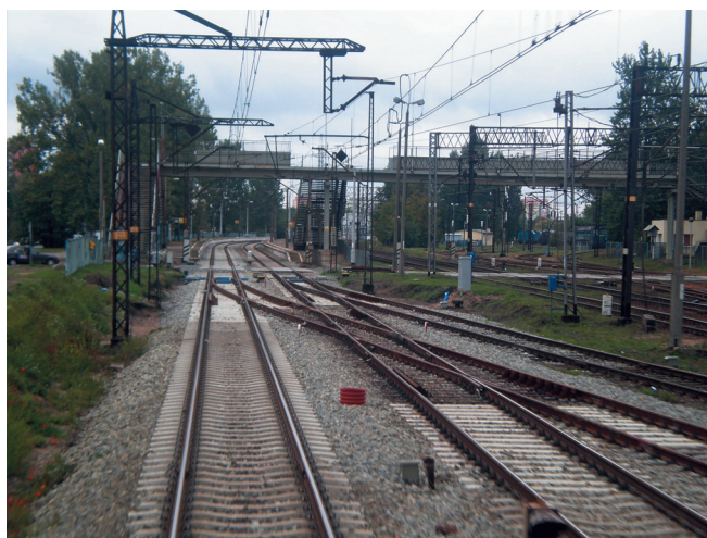
Fot. 2. Wymienione rozjazdy na stacji Bydgoszcz Wschód (14.09.2013 r.)
