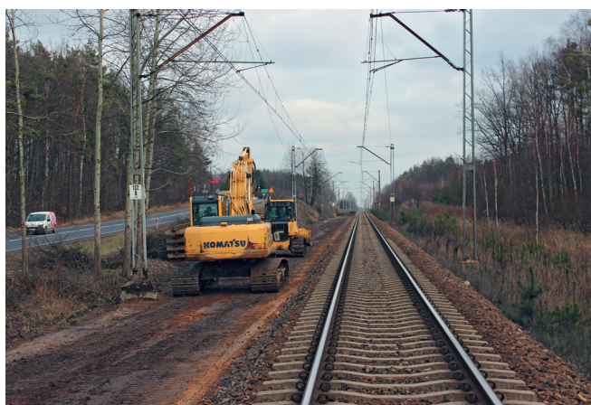
Fot. 6. Roboty podtorzowe w torze nr 1 na odcinku linii nr 61 Częstochowa Stradom–Fosowskie (13.01.2014 r.)
