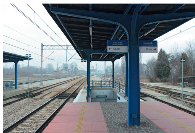
Fot. 3. Peron na stacji Pyskowitz na linii nr 132. Roboty wykonane zostały ze środków krajowych w ramach WPIK do roku 2015 (14.01.2014 r.)
