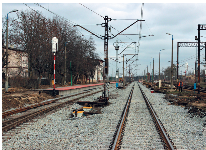
Fot. 7. Roboty na stacji Herby Stare na odcinku linii nr 61 Częstochowa Stradom–Fosowskie (13.01.2014 r.)
