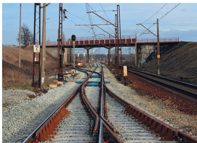
Fot. 9. Rozjazdy po wymianie na stacji Lisów na odcinku linii nr 61 Częstochowa Stradom–Fosowskie (13.01.2014 r.)
