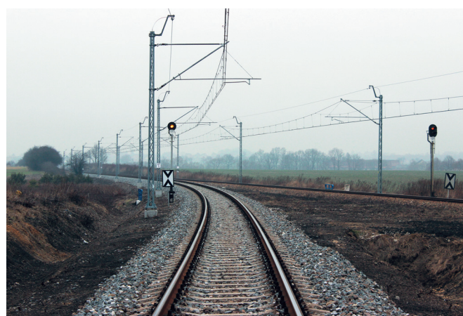
Fot. 4. Rewitalizacja na szlaku Paczyna–Toszek. Tor nr 2 na podkładach INBK7 po wykonanych robotach – wymianie szyn, oczyszczaniu podsypki i podbiściu. Roboty wykonane zostały ze środków krajowych w ramach WPIK do roku 2015 (14.01.2014 r.)
