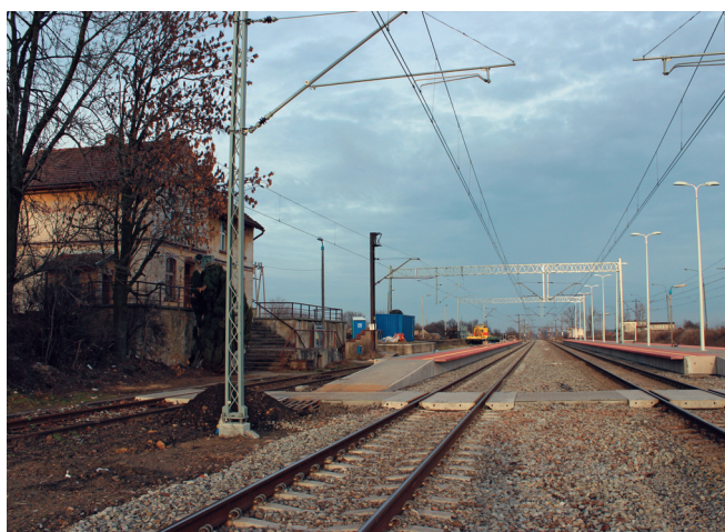
Fot. 10. Stacja Kochanowice na linii nr 61 po wykonanych robotach budowlanych (13.01.2014 r.)
