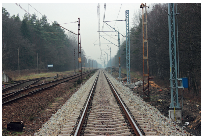
Fot. 5. Tor nr 1 po kompleksowej wymianie nawierzchni i sieci trakcyjnej na stacji Szymiszów na odcinku linii nr 132 Błotnica Strzelecka–Opole Groszowice (14.01.2014 r.)
