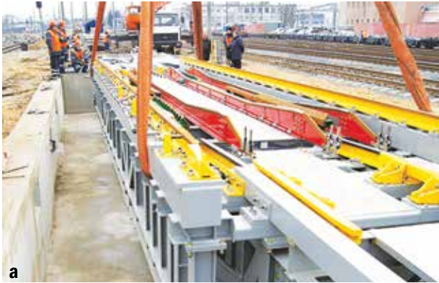
Stanowisko przestawcze w Brześciu na Białorusi: a) podczas budowy (14.01.2015 r.), b) po zakończeniu budowy (21.05.2015 r.). Fot. W. W. Samosiuk
