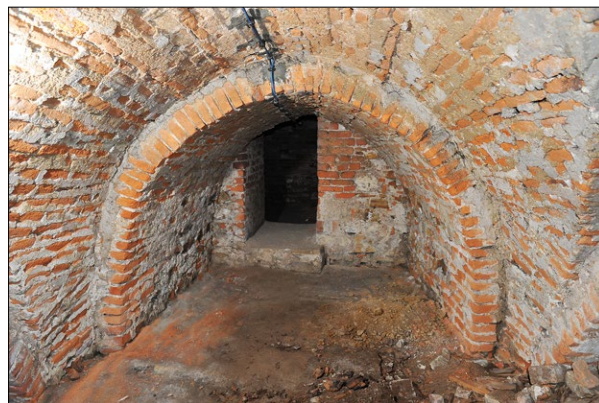
Ryc. 8. Widok podziemi bazyliki przed remontem, krypta pod północną nawą boczną; archiwum M. Piórkowskiego.
