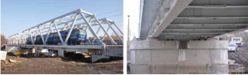
Fot. 1. Widok mostu w czasie badań i widok od spodu
