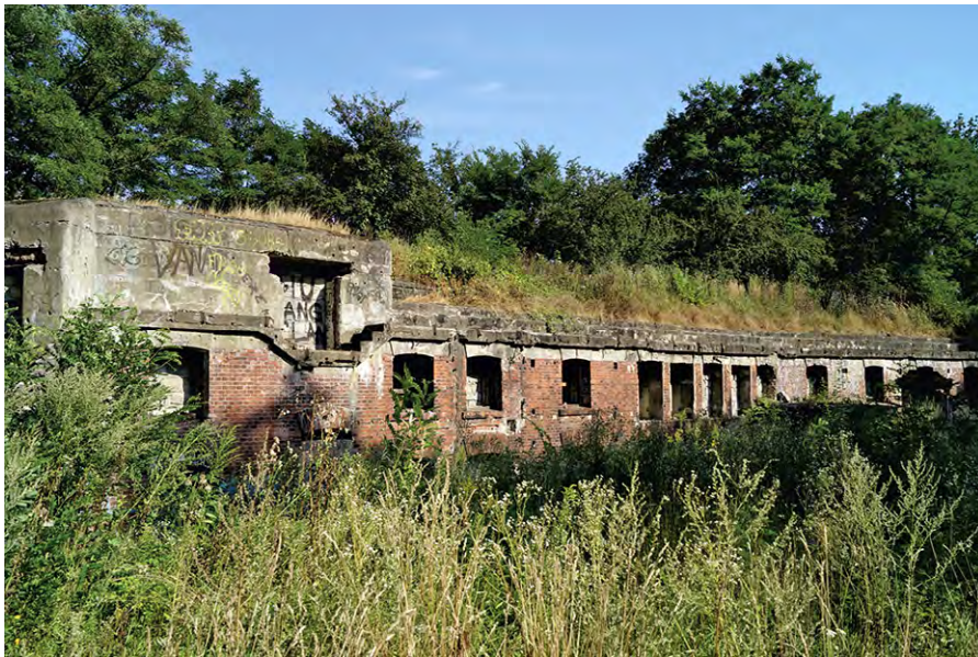
Ryc. 4. Fort Lasówka – jeden z najbardziej zniszczonych fortów Twierdzy Kraków
