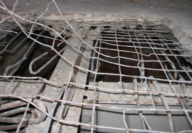
Fot. 6. Odkrywka w stropie nad parterem. Ruszt z kształtowników stalowych, na których oparte są prefabrykowane płyty żelbetowe
