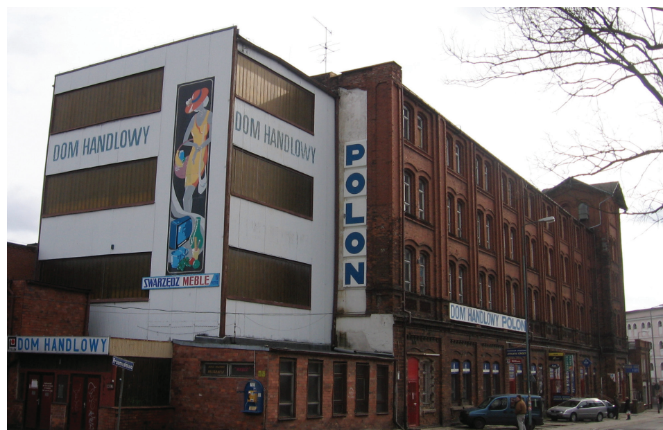
Fot. 1. Budynek POLON przed adaptacją
