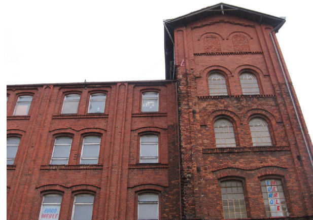
Fot. 3. Przemurowane trzy kondygnacje korpusu i dwie kondygnacje wieży
