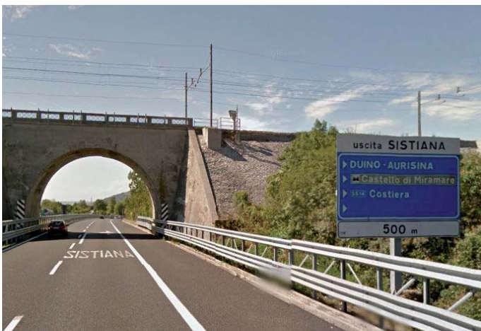
Fot. 7. Dodatkowa tablica z informacjami o miejscowościach na autostradzie A4 we Włoszech [10]
