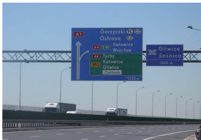
Fot. 3. Tablica przeddrogowskazowa na węźle „Gliwice Sośnica” (fot. K. Gasz)
