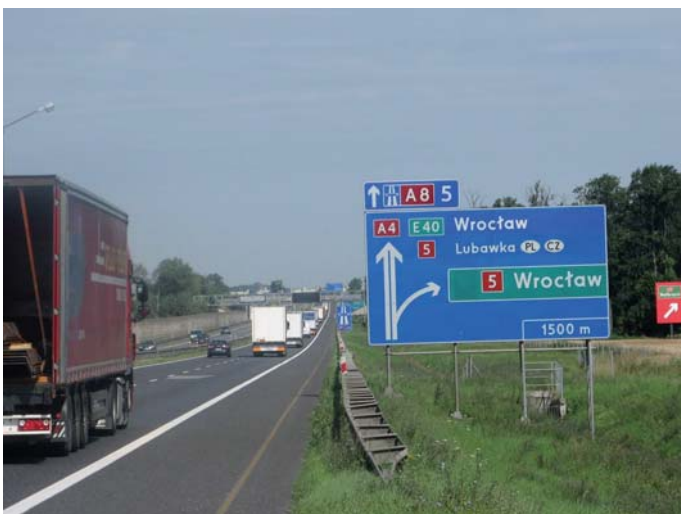
Fot. 1. Tablica przeddrogowskazowa na węźle „Bielany Wrocławskie” (fot. K. Gasz)
