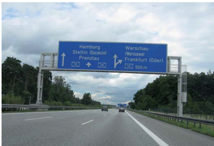
Fot. 4. Tablica przeddrogowskazowa na autostradzie A10 w Niemczech (fot. K. Gasz)
